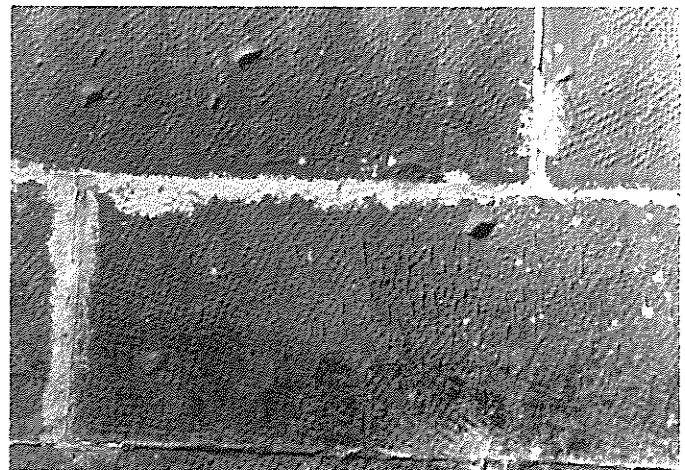
Fig. 8 — Pedra trabalhada com a escoda e retocada com a bujarda, onde se nota um buraco de garra de grua.
