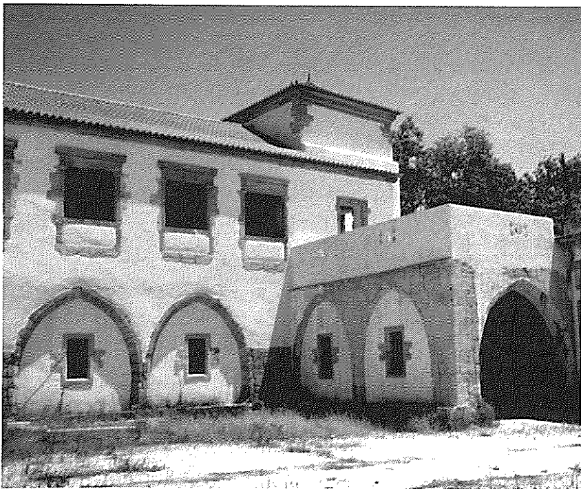
Paço de Belas, obras realizadas por D. Beatriz (mãe de D. Manuel I). As arcadas do piso inferior foram descobertas durante as últimas obras de restauro (1992). As janelas no meio dos arcos foram projectadas pelo arq. Raul Lino.
