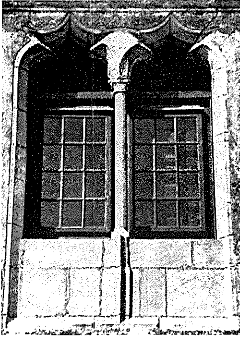
Paço de Sintra: janela pré-manuelina da fachada Oeste. Trata-se de uma variante sobre um arco de querena abatido.
